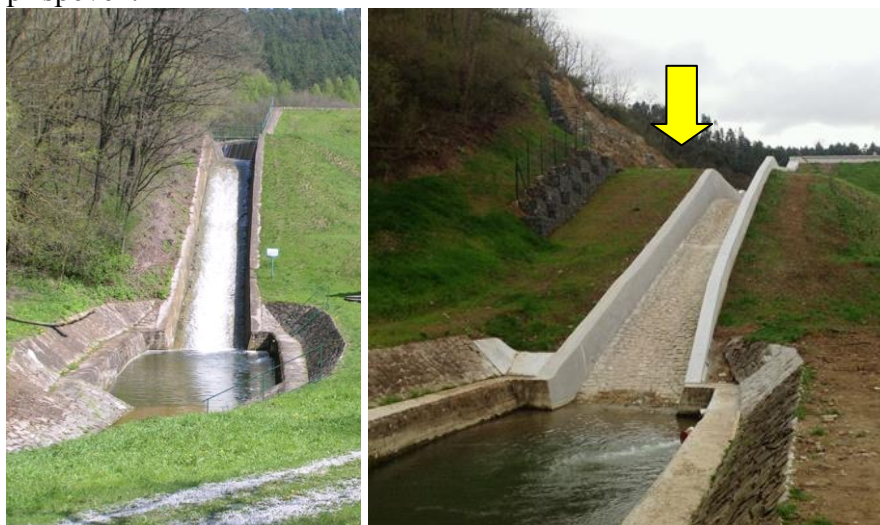
Obr. 3 VD Suchomasty – zkapacitnění skluzu v kombinaci s přírodní bermou
