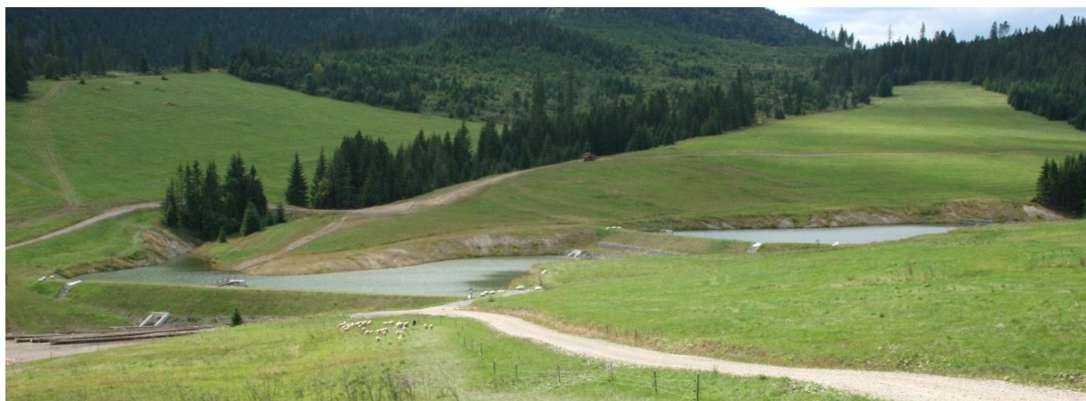
Obr. č. 2 Protipožiarne nádrže Ždiar-Strednica
