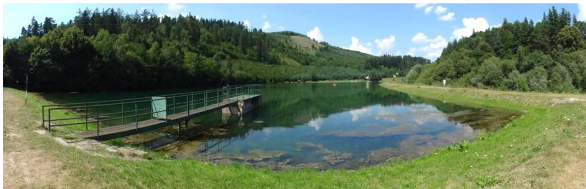
Obr. č. 1 Vodná nádrž Levoča
