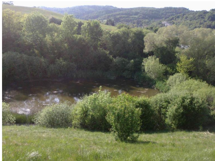
Obr. 5 Horná Komorovská nádrž, zarastená nádrž a hrádza (vpravo)
