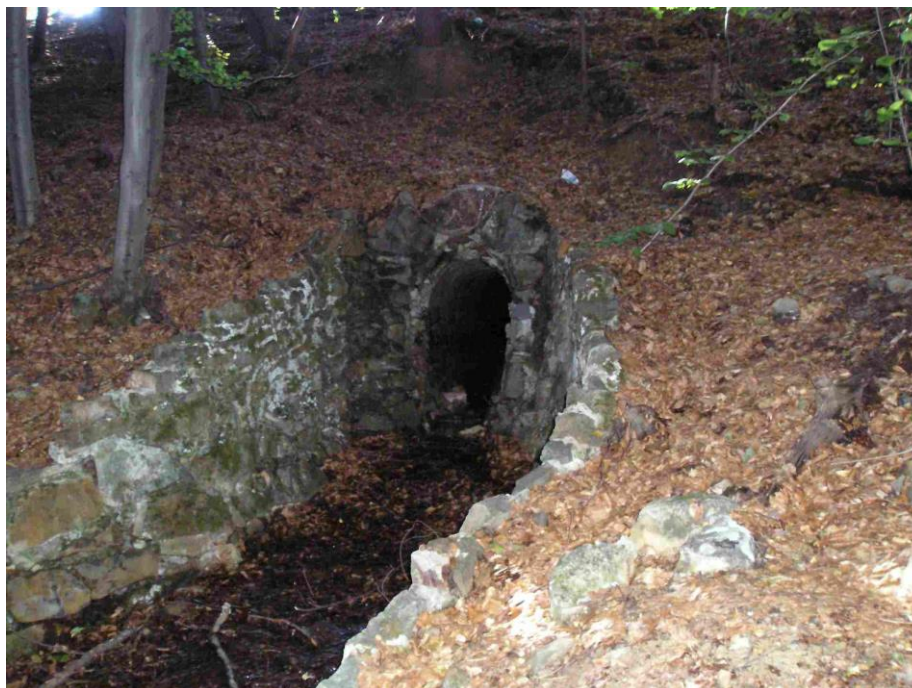
Obr.3 VS Červená studňa, vchod do štôlne dnového výpustu
