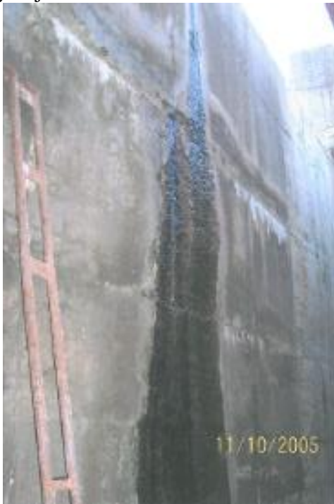
Foto: archív SVP š.p.: Vodná nádrž Jablonica – priesaky cez betónové konštrukcie bezpečnostného priepadu a funkčného objektu
