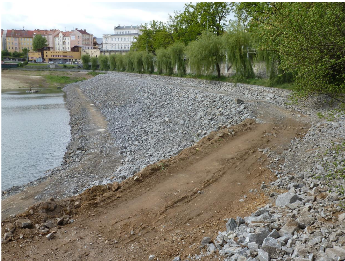
Obr. 5 Realizace přispávky návodního svahu
