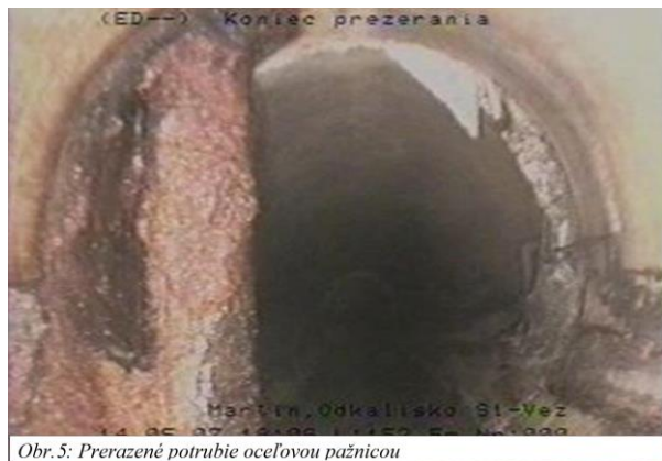
Obr.5: Prerazené potrubie oceľovou pažnicou
