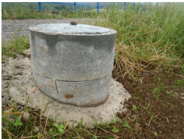
Obr. č. 10 Nový pozorovaný výškový bod KVB 8
