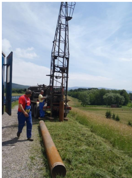
Obr. č. 3 Pojazdná vrtná súprava UGB-50M na podvozku PV3S (10.6.2013)
