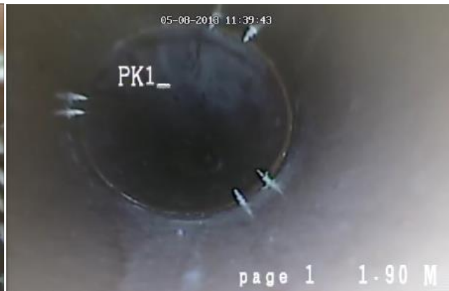
Obr. č. 7 Samorezné skrutky na spoji výpažníc sondy PK 1 (5.8.2013)
