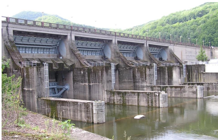
Obr. 2 Gravitačná betónová priehrada VS Nosice (bloky výpustného zariadenia)
