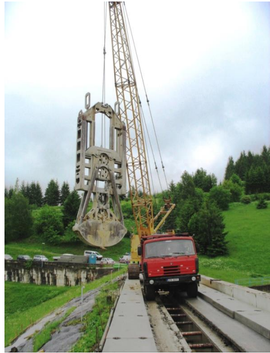
Obr. 5 VD Karolinka – realizace kopané těsnící stěny
