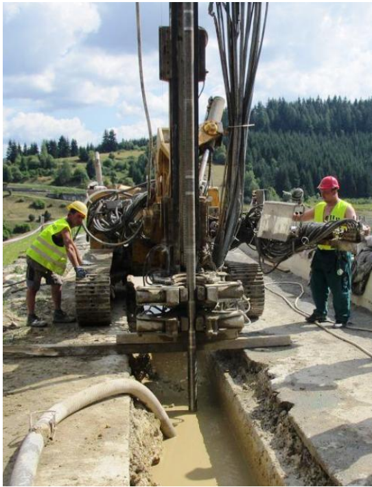
Obr. 4 VD Karolinka – realizace TI v zavázání hráze
