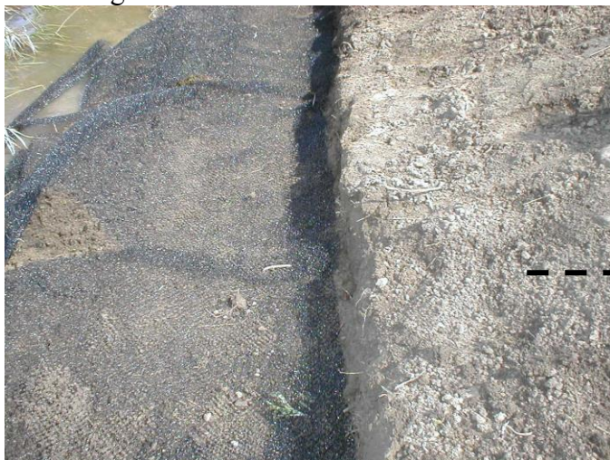
Obr. 2 Geosít' není mnohdy nutno osadit po celém svahu, možné je vytvoření zářezu nad oblastí výběhu vlny a zakončení osazení geosítě zde. Pásky geosítí se překrývají (cca 10 cm).
