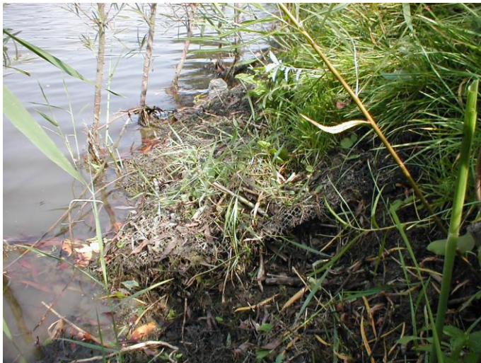
Obr. 6 Stav stabilizovaného břehu pomocí geosyntetik po cca 5 letech. Ústup břehu je patrný na srovnávací ploše stabilizované pouze vegetačně.
