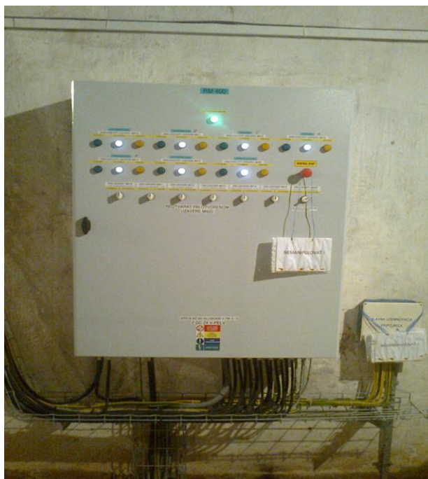
Obrázok 4: Zasívadlové uzávery – ovládanie v strojovni Johnsonov
