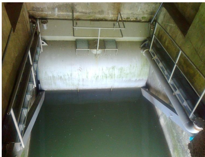
Obrázok 5: Povodňový dnový výpust - segment
