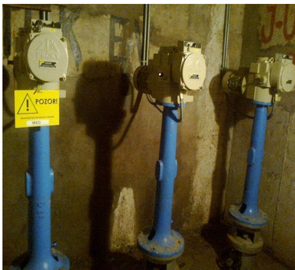
Obrázok 3: Zasúvadlové uzávery – po výmene
