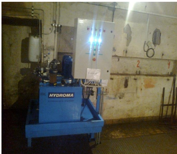
Obrázok 2: Hydraulický agregát – strojovňa Johnsonov
