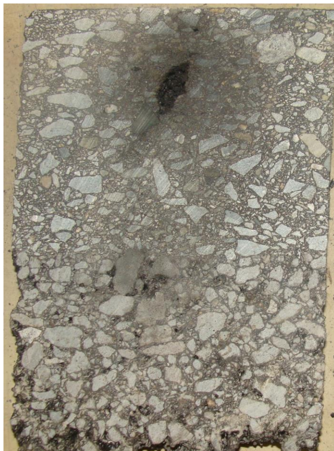
Obr. 8: Odvrt z AB pláště se skrytou poruchou průměru 1,5 až 2 cm
