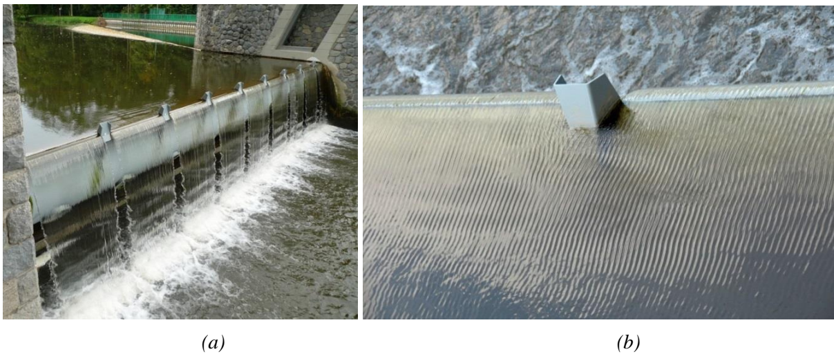
Obr. 7: Projevy nežádoucího chvění na reálné konstrukci (a) přepadový paprsek; (b) hladina ve zdrži
